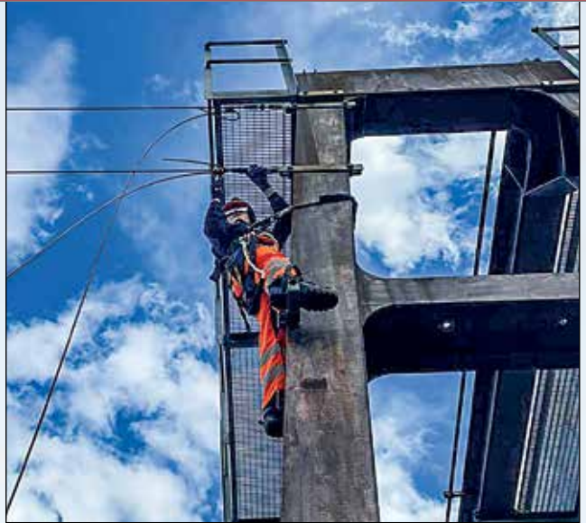
▲ Anna Jost: Arbeiten an der Fahrleitung mit himmlischem Hintergrund
